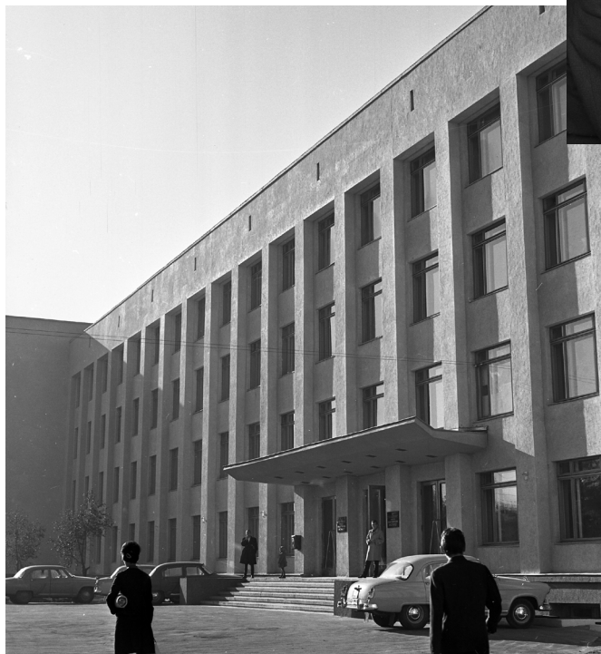
Здание 1-го корпуса МРТИ, 1964 г.
