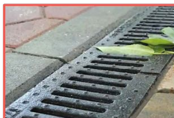
Металл над ливнёвками
